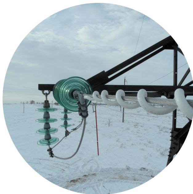
**Спиральные гасители вибрации работают во всех диапазонах частот, что позволяет стабилизировать поведение провода в любых условиях. Выполнены из композитных материалов, имеют минимальное время на монтаж, не требуют обслуживания в процессе эксплуатации.**
