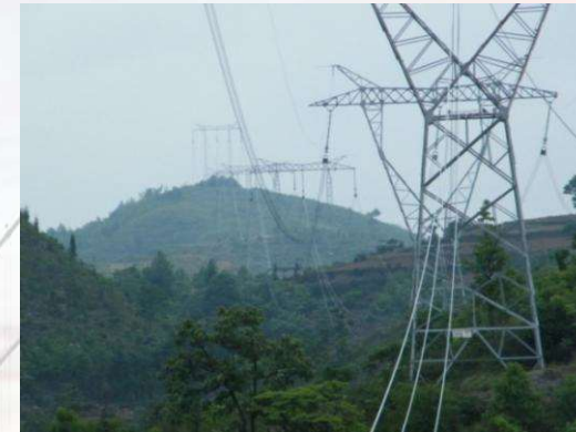
Jingbei - Nanjing line ( \pm 800\text{KV}, 1000\text{mm}^2 )
