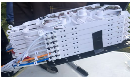
Рис. 8. Пример использования оптических модулей одинакового цвета
