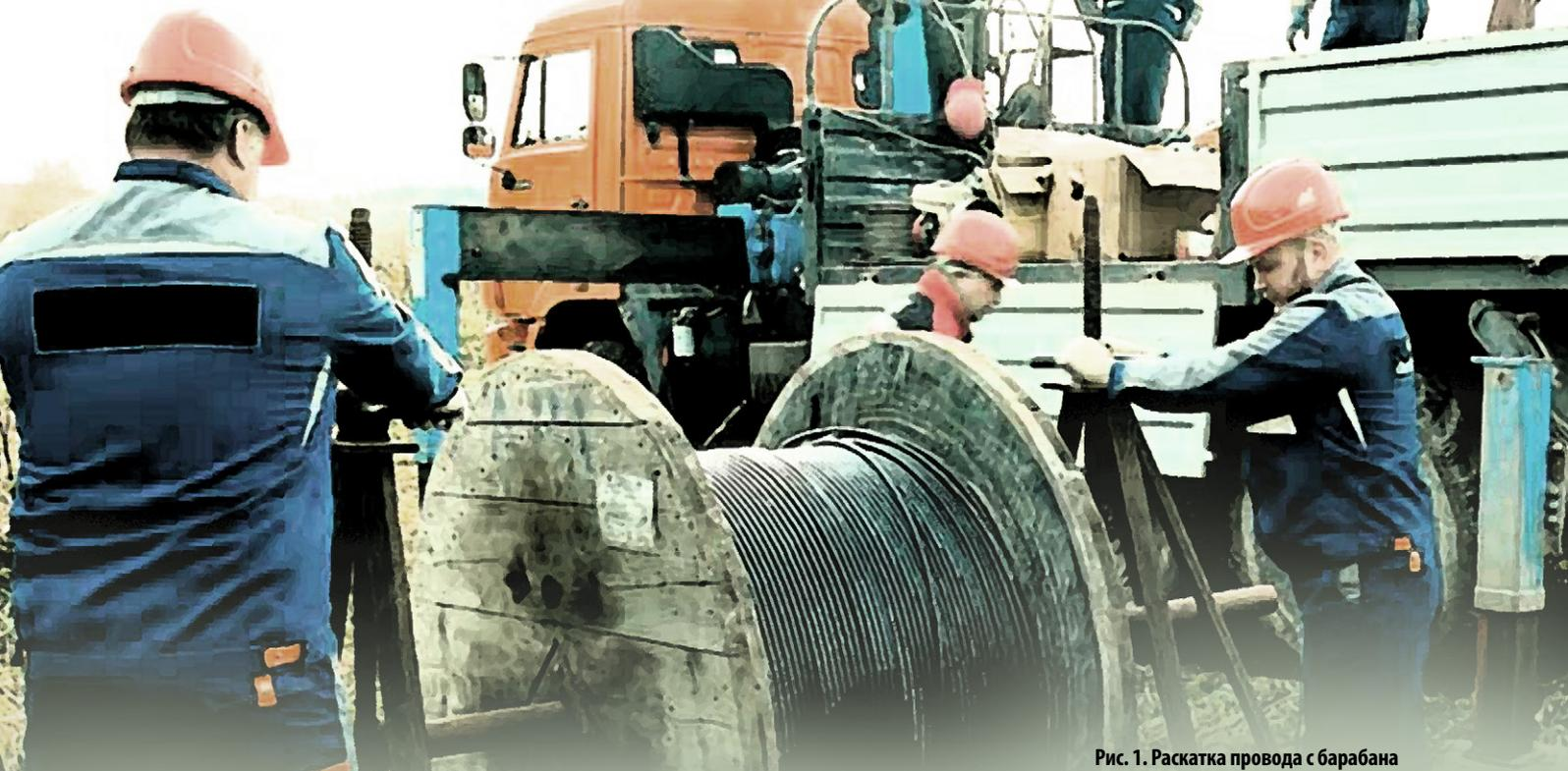
Рис. 1. Раскатка провода с барабана
