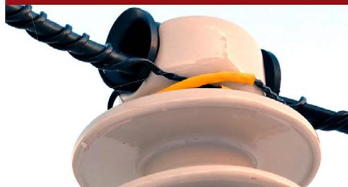
Рис. 8. Монтаж спиральной вязки
