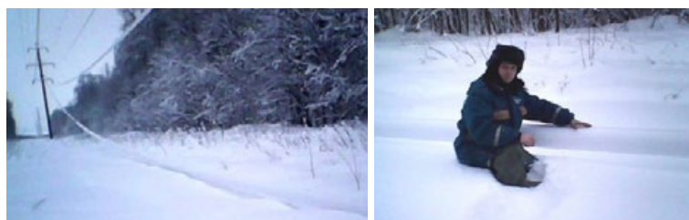
Рис. 5. ВОК лег на землю под тяжестью гололеда
