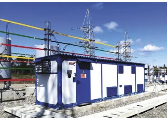
Внешний вид контейнера СТК 35 кВ с использованием КРУ и устройств FACTS на основе тиристоров и приборов IGB
