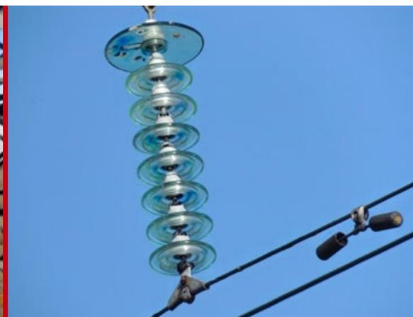
Рис. 6. Повреждение аэродинамического изолятора от птичьего помета на ВЛ 110 кВ. Остальные изоляторы не повреждены
