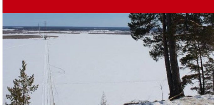
Рис. 6. ВЛ 110/220 переход через р. Лена с применением ОКФП
