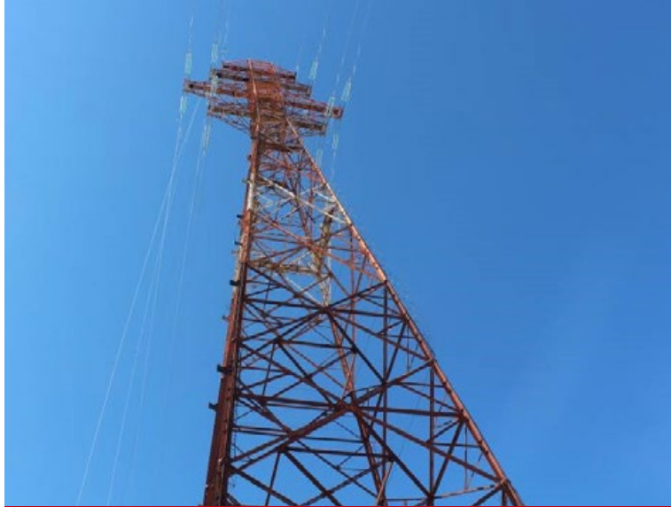
Рис. 5. Опоры ЛЭП перехода через Лену
