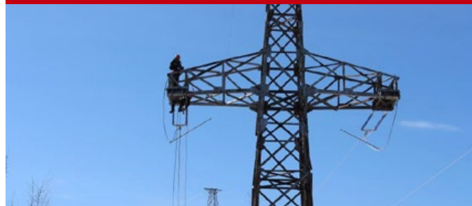
Рис. 7. Монтаж муфты для ОКФП на опоре
