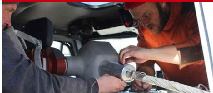
Рис. 8. Монтаж муфты для ОКФП
