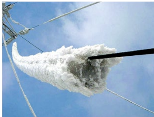
Рис. 3. Гололедно-изморозевые отложения на элементах ВЛ
