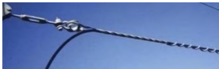
Рис. 6. Натяжной спиральный зажим без протектора и спиральный виброгаситель
