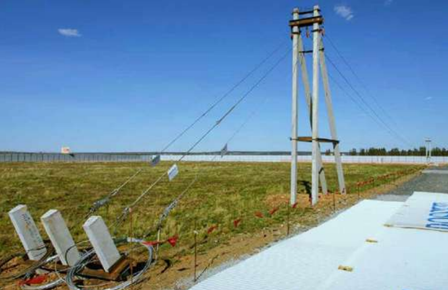
Рис. 5. Стенд на Заводе «Инкаб» для тестирования системы контроля начала гололедообразования
