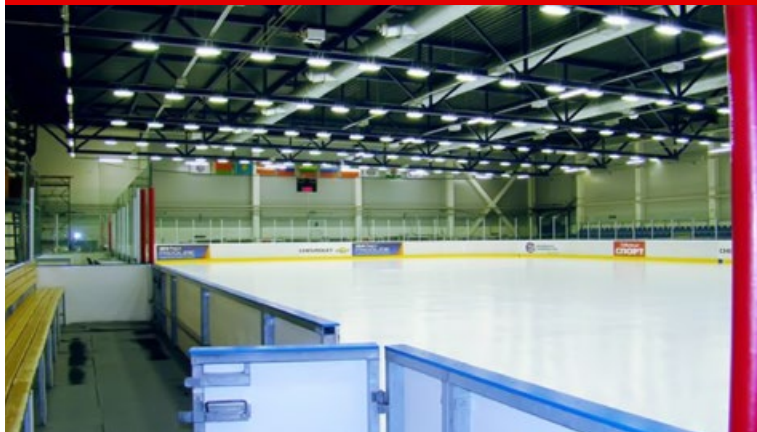
Рис. 4. Светодиодное освещение Казанского Ледового дворца спорта (тренировочной базы хоккейного клуба «АК БАРС»). Светильники ТИС-17-2 с индексом цветопередачи более 90
