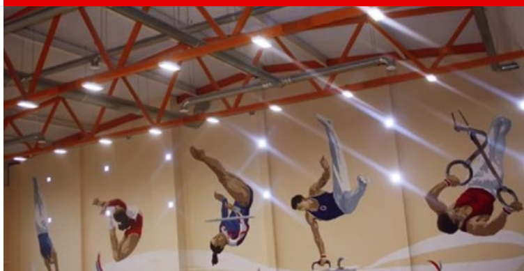
Рис. 2. Светодиодное освещение Детско-юношеской школы Олимпийского резерва № 3 Калининского района Санкт-Петербурга (центральный гимнастический зал). Светильники ТИС-17 и ТИС-17-2
