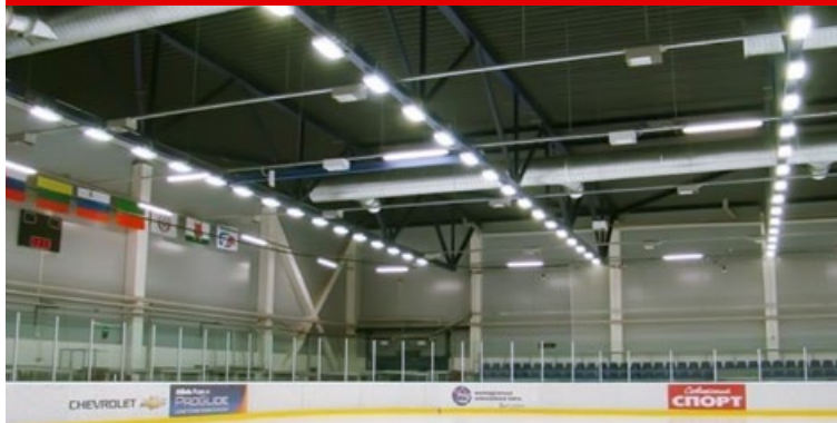
Рис. 1. Светодиодное освещение Казанского Ледового дворца спорта (тренировочной базы хоккейного клуба «АК БАРС»). Светильники ТИС-17-2
