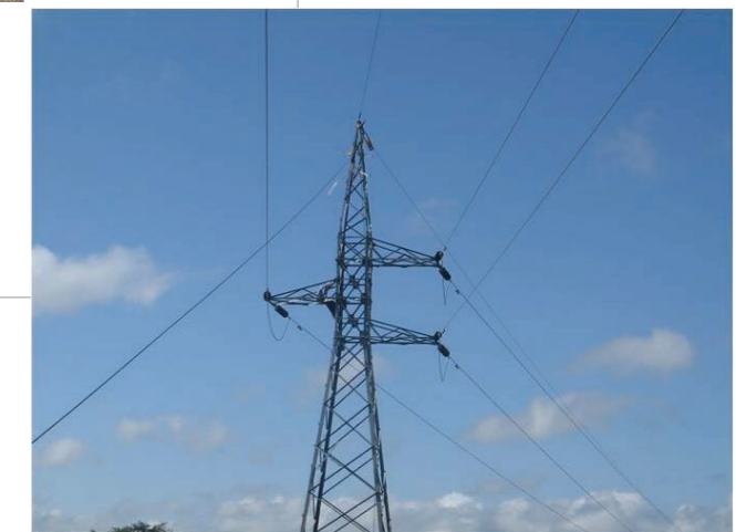
Монтаж кабеля OPGW
