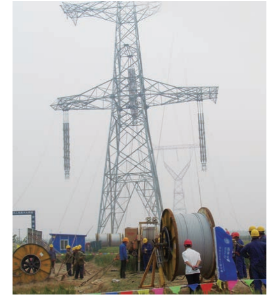
Прокладка кабеля OPGW
