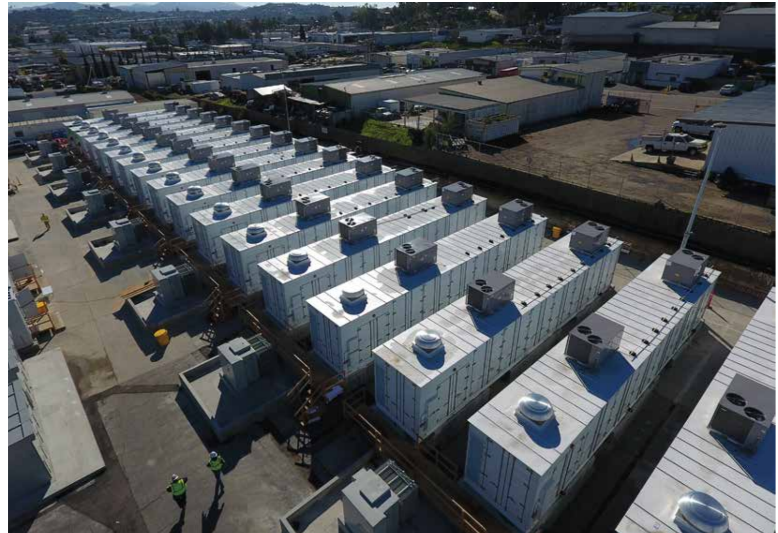
Рис. 3. Система накопления в Сан-Диего 30 МВт, емкость 120 МВт·ч
