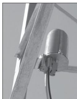
Монтаж на опоре
