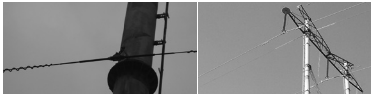
Монтаж на столбе
