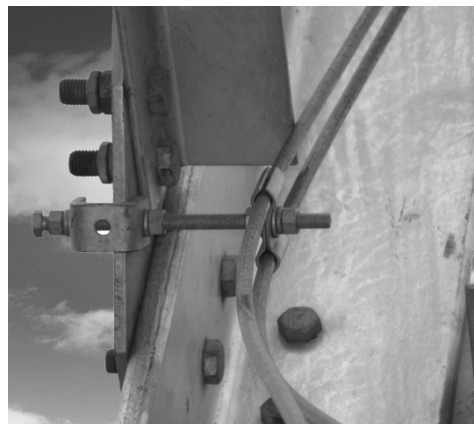
Монтаж на опоре
